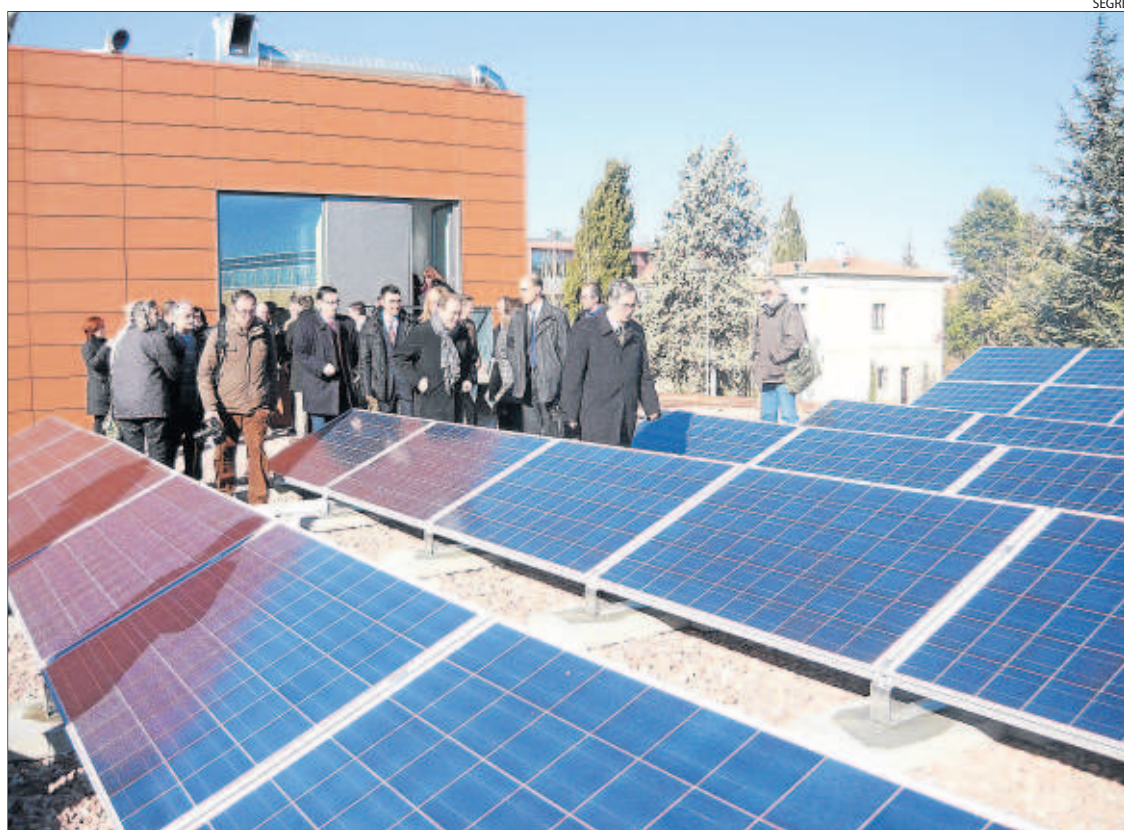
Panells fotovoltaics que es van instal·lar l'any passat a la facultat d'Agrònoms.
