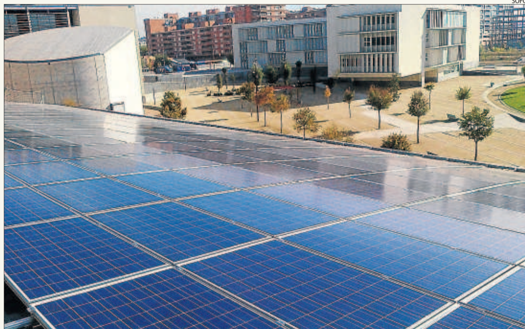
Panells solars instal·lats per Sofos sobre la coberta d'un edifici a la Universitat de Lleida.
