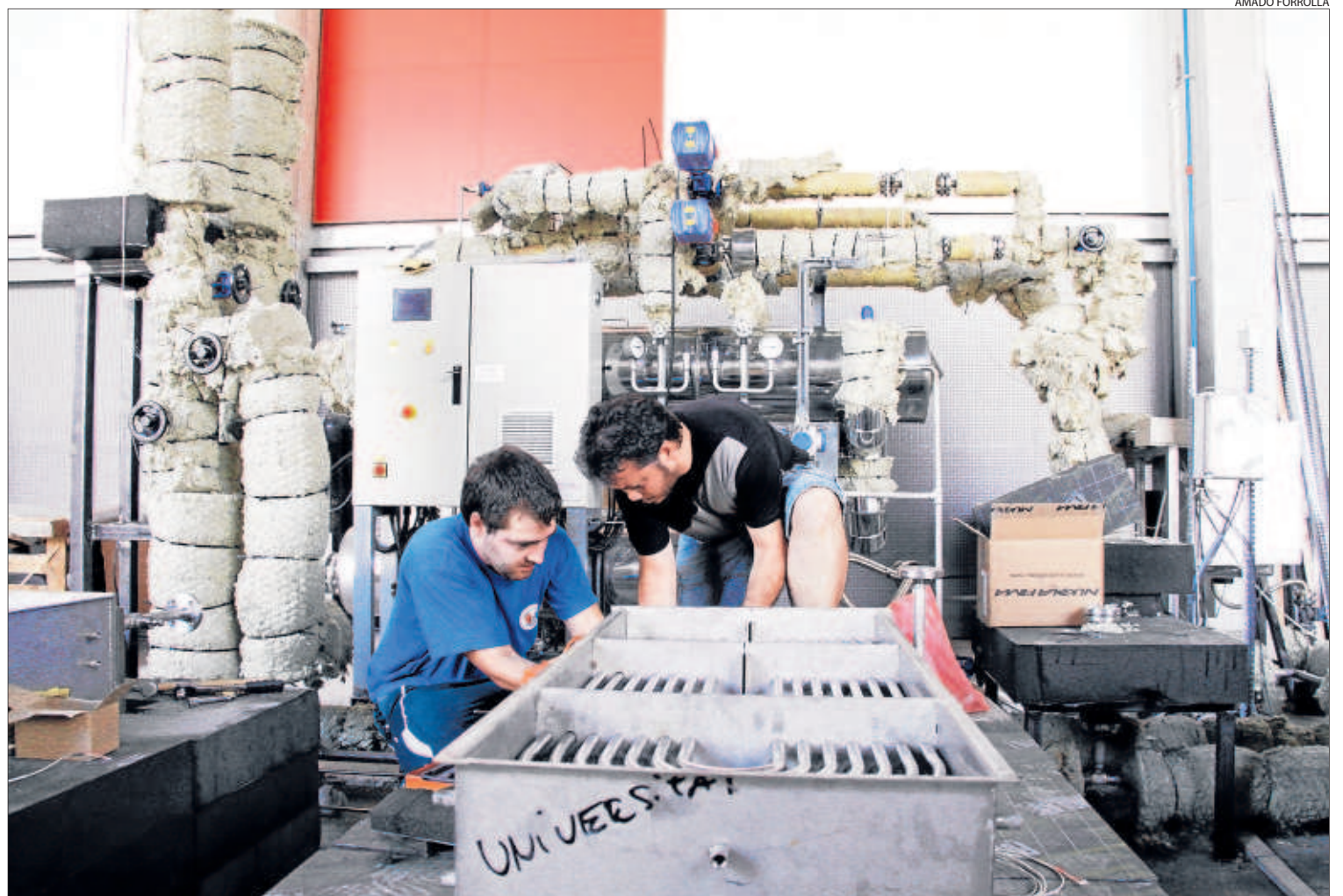
Un tanc de proves en què s'emmagatzema energia escalfant un material amb la calor generada per la caldera que hi ha a la part posterior.
