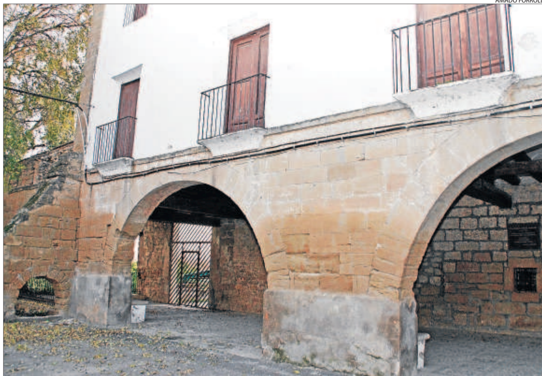
El sostre del porxo de l'ermita de Butsènit està en mal estat i la Paeria ordena reparar-lo.
