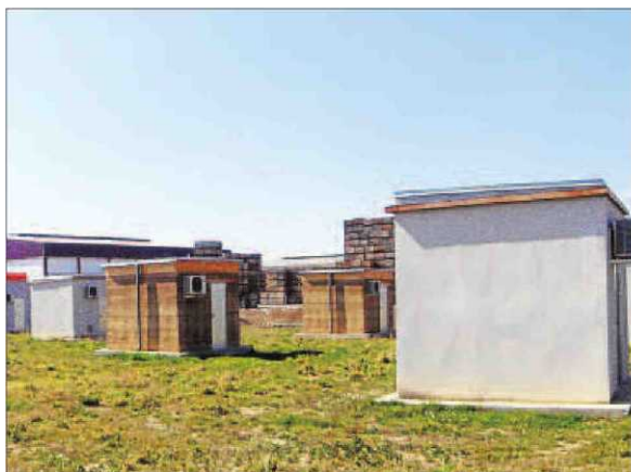
La instal·lació experimental del GREA, a Puigverd.
