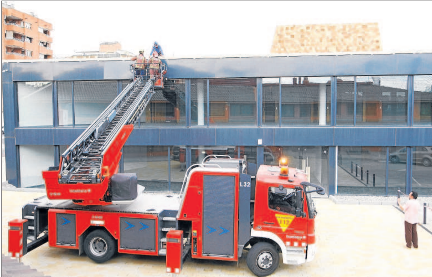
Els bombers van assegurar ahir les proteccions metàl·liques de les persianes de l'edifici annex a la Llotja.
