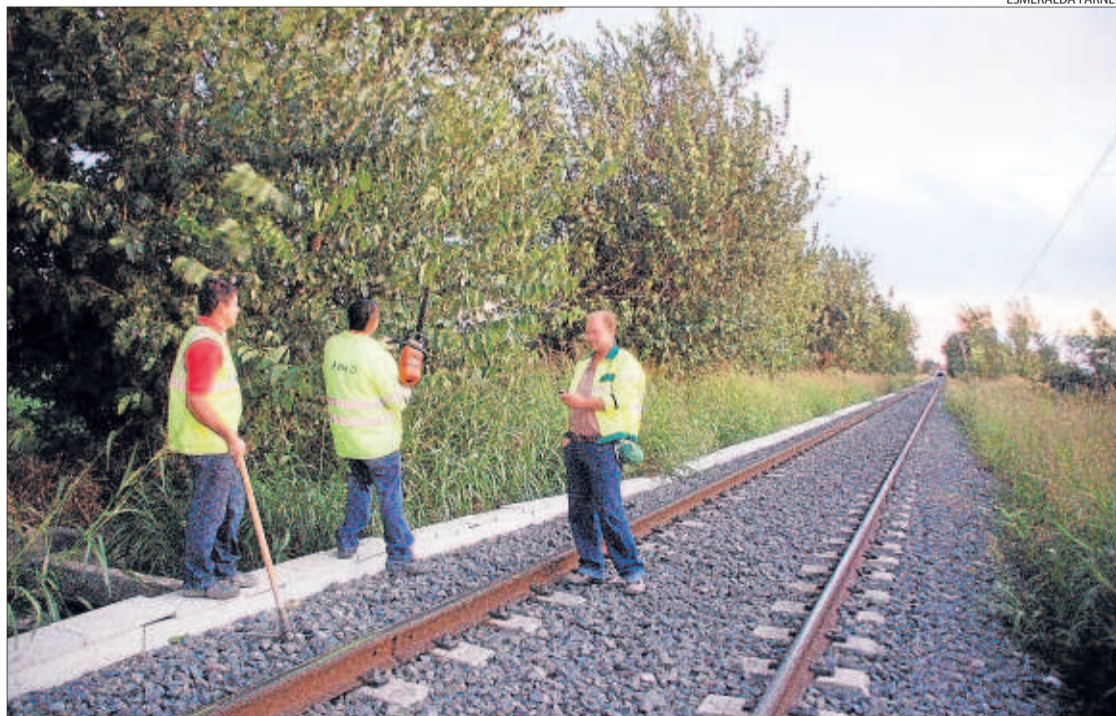
Els operaris d'Adif treballaven ahir a la tarda a la línia de la Pobla per reestablir-hi la circulació.
