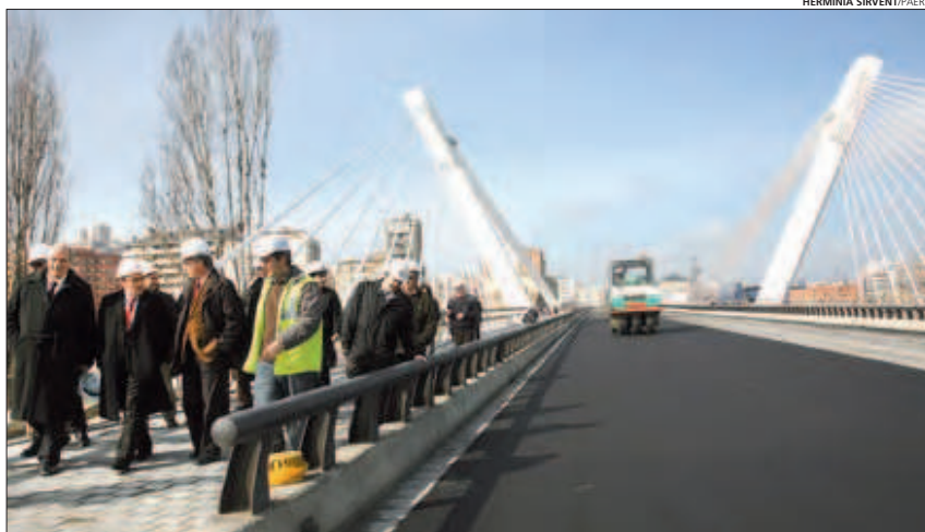
La infraestructura ja llueix la seva forma definitiva
