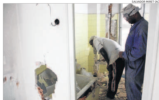
Alguns dels voluntaris que col·laboren en les tasques de buidatge interior
