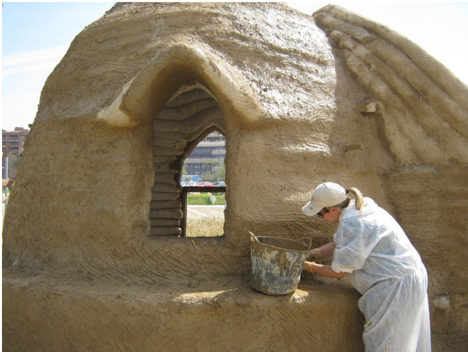
La construcció amb Superadobe
