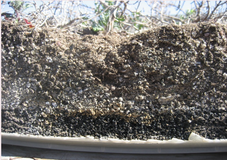
Composició de la coberta vegetal utilitzant el cautxú FOTO: G. PÉREZ
