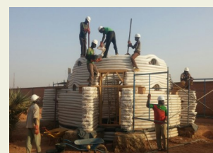
Obres del Centre Mèdic a Uagadougou
