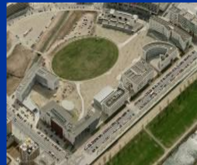
Vista aèria del Campus
