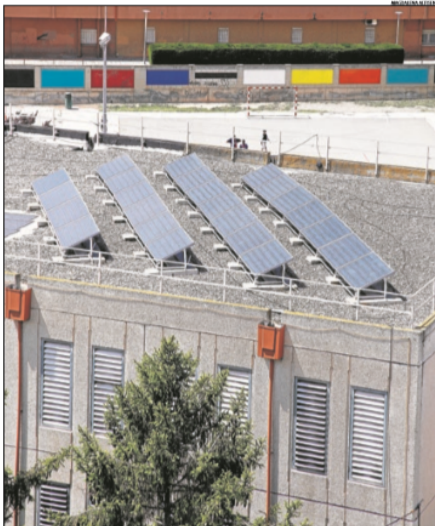
L'edifici de les escoles Joan XXIII de Lleida, a la taulada del qual es van instal·lar plaques fotovoltaiques.
